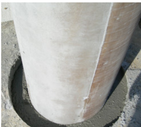
Osazení prefabrikovaného sloupu
